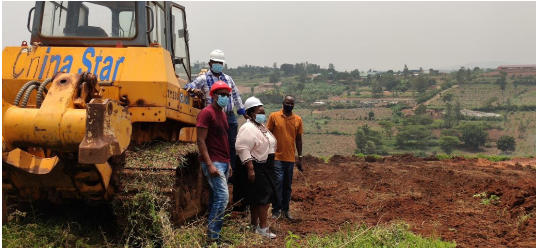
Erste Bauarbeiten für die neue Ofenfabrik
