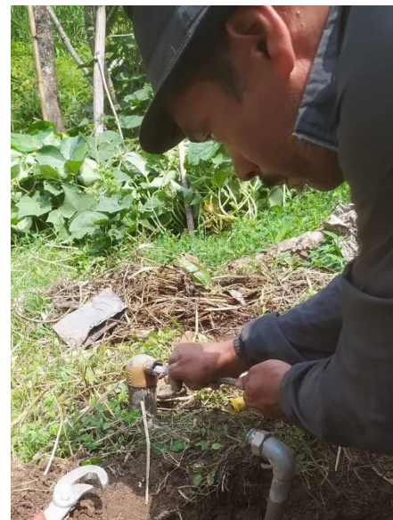
Defekte Gasleitungen werden ausgetauscht
