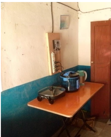
Bild 4: Statt auf offenem Feuer zu kochen, kann die neu installierte elektrische Kochecke genutzt werden und vor gesundheitsschädlichem Rauch schützen
