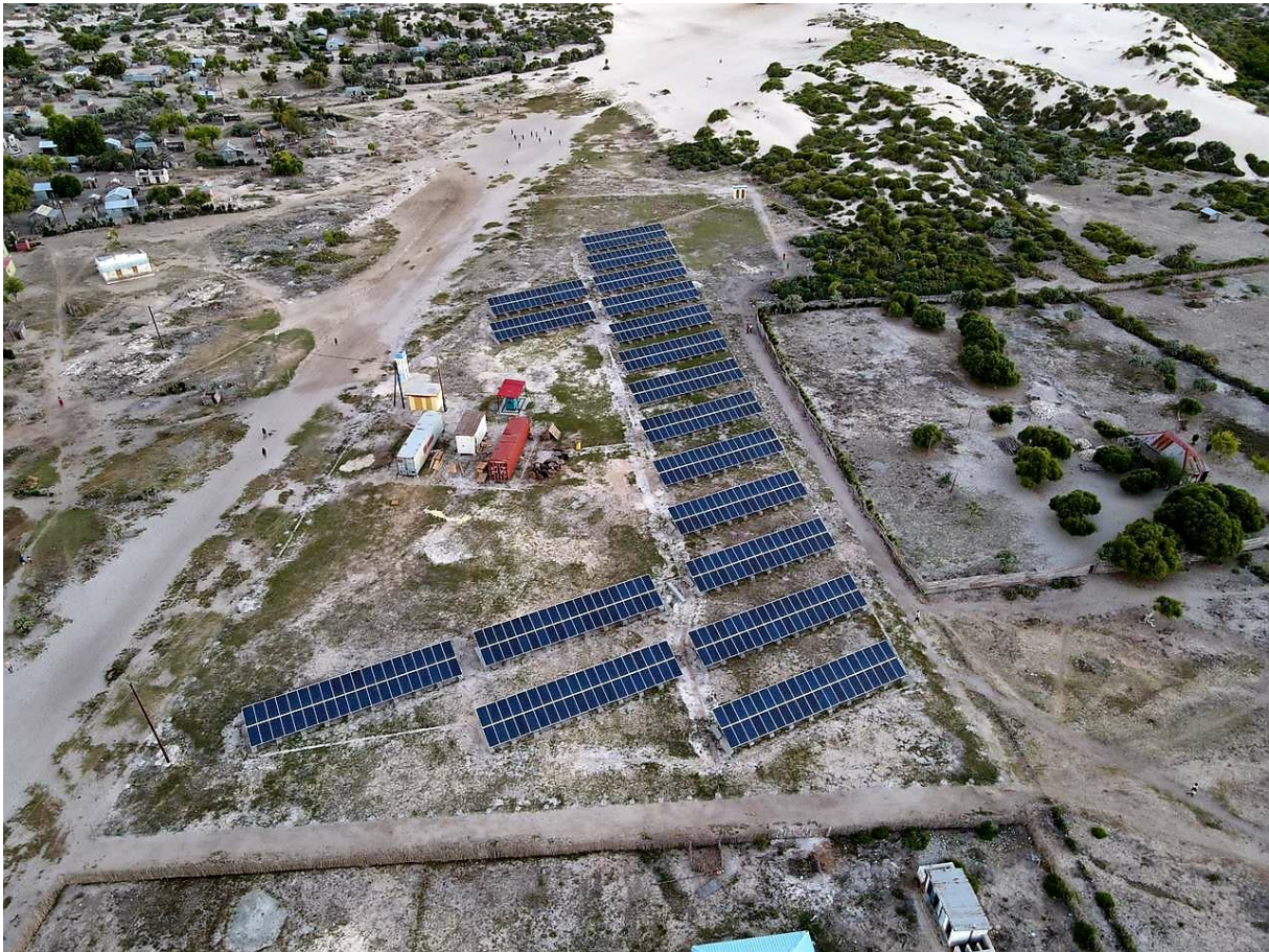
Bild 1: Fertiggestellte PV-Anlage in Anakoa
