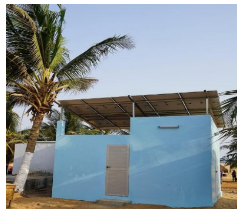
Station centrale avec système PV en toiture
