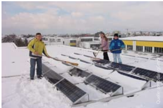
Die Solaranlage produziert auch im Winter klimafreundlichen Strom
