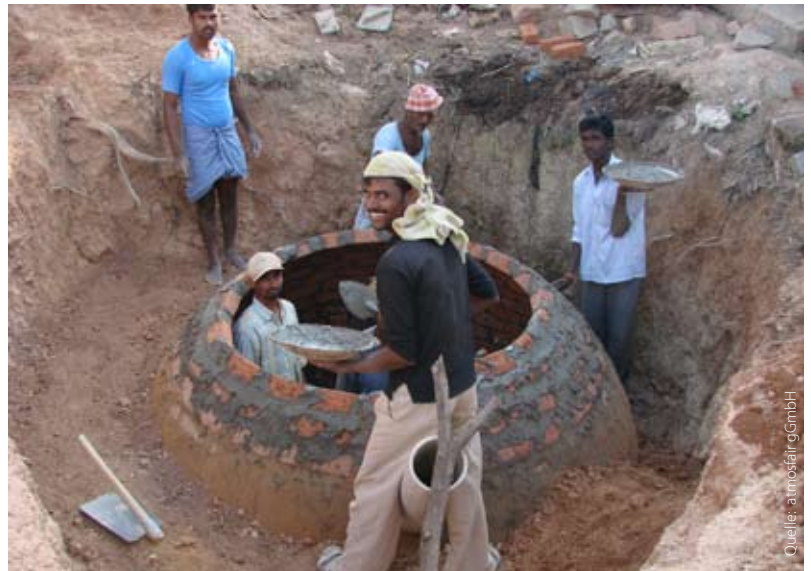
Der Kuhdung wird in der unterirdischen Biogasanlage zu einem fast geruchslosen Gas fermentiert.
