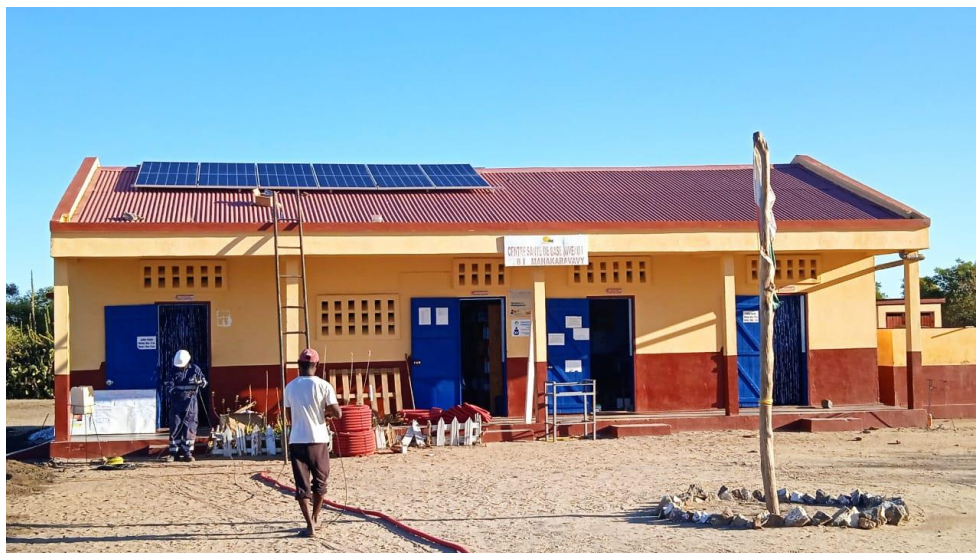
Fertig installierte Solaranlage auf dem Dach des Gesundheitszentrums in Manakaravavy
