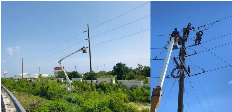
Das Team von Maranatha Energy montiert die Übertragungsleitung nach El Toro
