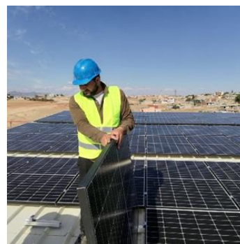
Hoshyar von unserem Partner Topway installiert die Solatrmodule auf dem Dach der Schule
