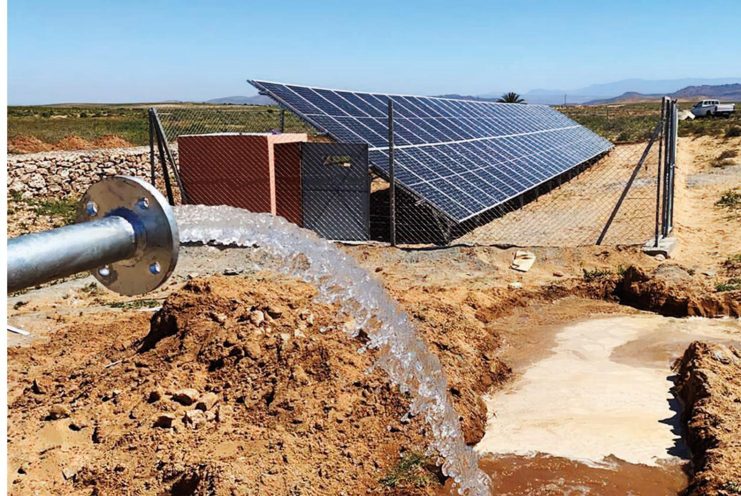
Die Wasserpumpen werden komplett mit Solarenergie betrieben
