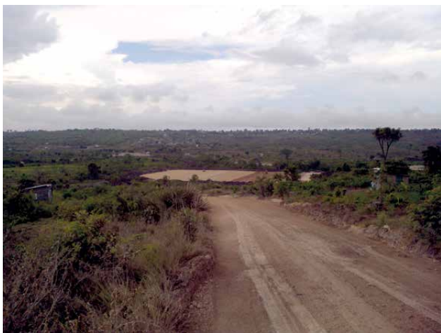
Die Baustelle, auf der bald 25 Tansanier arbeiten
