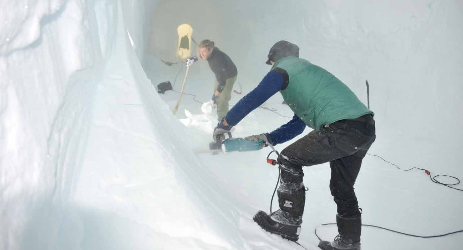
Mit Kettensäge und Schaufel bearbeiten Wissenschaftler/Techniker das Eis auf Grönland, um das Tunnelsystem für das EastGRIP Camp zu errichten. Foto: Alfred-Wegener-Institut | Foto: Sepp Kipfstuhl
