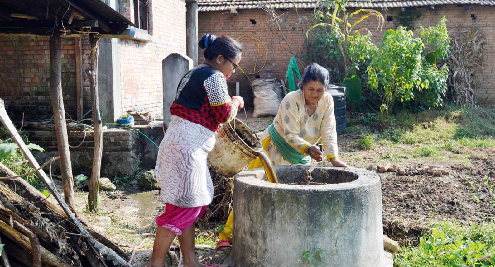
Zwei Frauen füllen Kuhdung in ihre Biogasanlage
