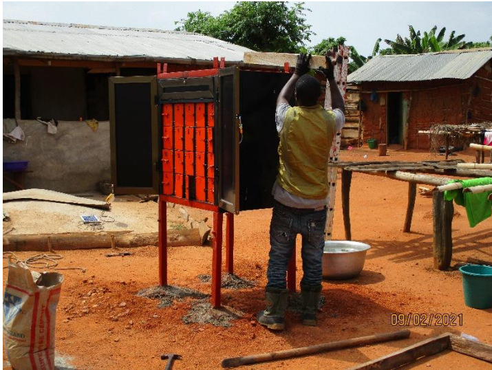
Aufbau eines Solarkiosks
