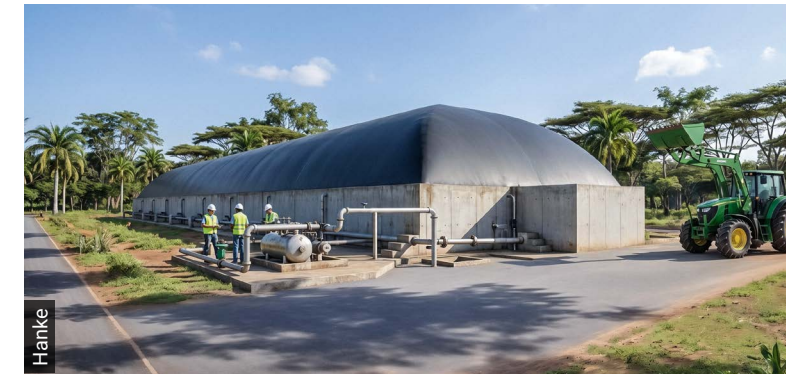
V. r.: Tobias Hanke, John Castillo (SENA) und die Angestellten der Firma Hanke errichten eine in Kolumbien bisher einzigartige Biogasanlage (siehe Illustration). Das Membrandach verschließt die Grube so dicht, dass sich das entstehende Biogas kontrolliert abfangen und verwerten lässt.
