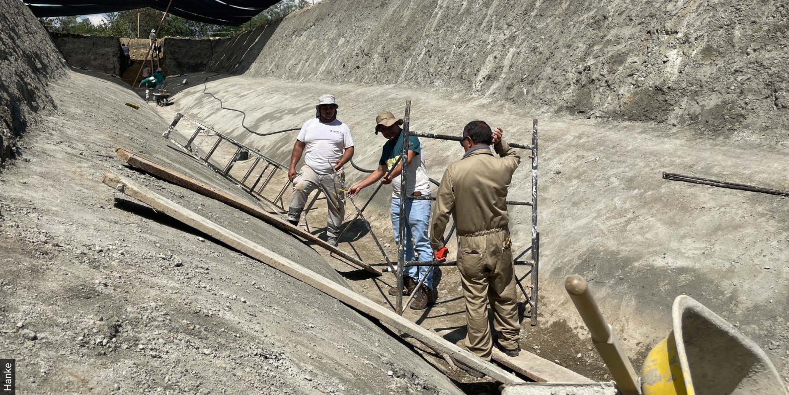
Bauarbeiter gießen die Grube der Biogasanlage mit Beton aus.
