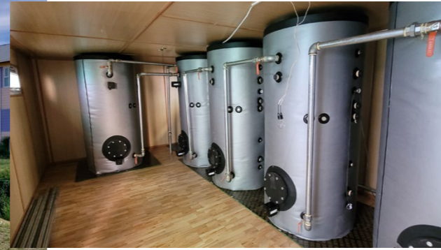
Latentwärmespeicher halten die Wärme über einen langen Zeitraum und geben diese bei Bedarf wieder ab
