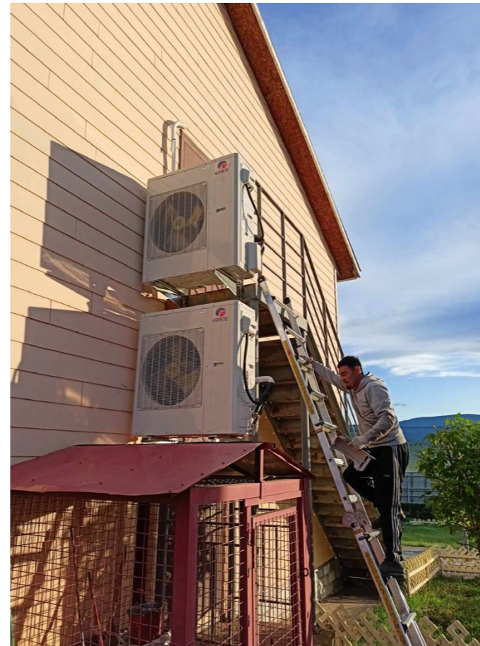
In der Mongolei installiert ein Monteur Klimaanlagen an einer Schule
