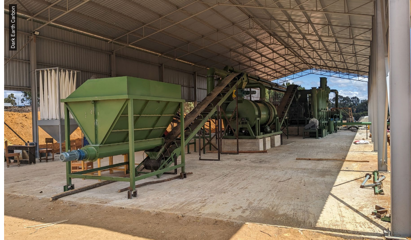
Einsatzbereite Pyrolyseanlage in Mafinga
