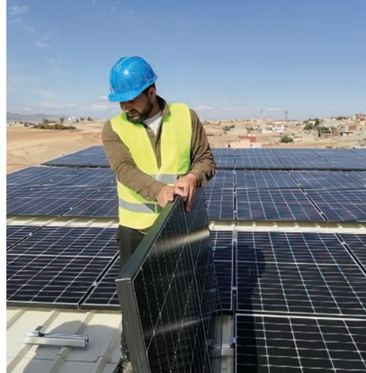
Der Elektriker Basem von unserem Partner Topway installiert die Solarmodule auf dem Dach der Schule
