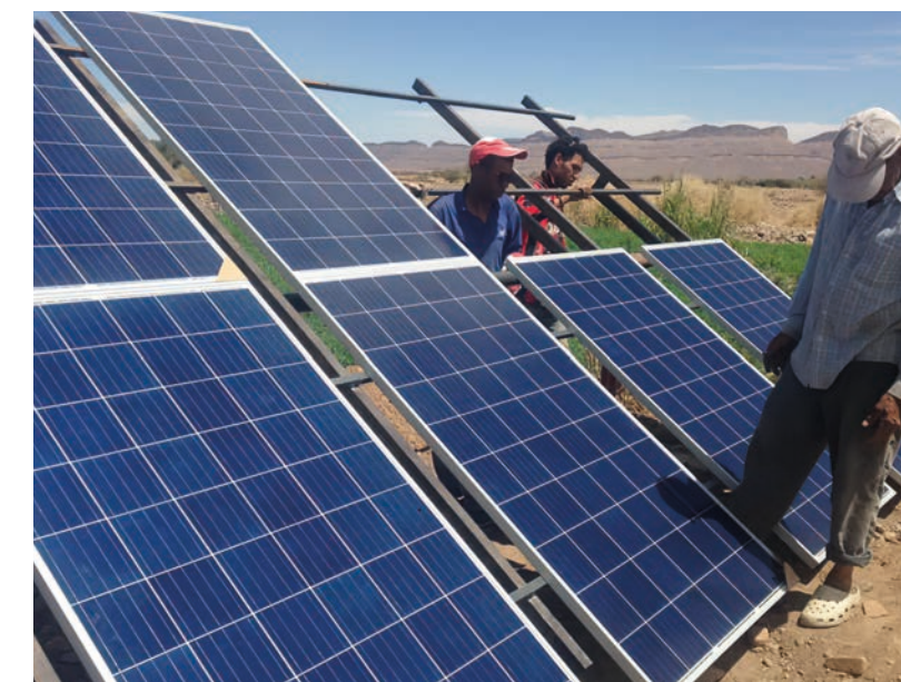
Lokale Installateure bei der Montage einer 9,8 kW Solaranlage
