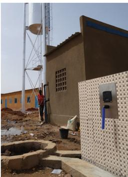
Kernanlage mit Wassertank, Technikraum für die Wasseraufbereitungsanlage und Zapfstelle ©atmosfair
